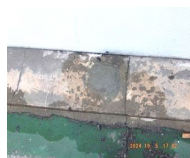
ポール撤去後コンクリート注入
