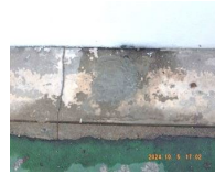
ポール撤去後コンクリート注入
