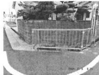
多治井183-3水路防護柵設置 北部整備にて処置(9月)
