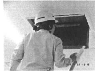
空調機フィルター清掃 小池田電工にて年2回(5・11月)
