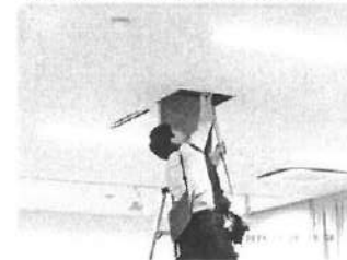
消防設備点検 小池田電工にて年2回(5・11月)
